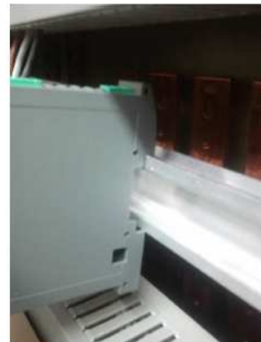
MONTAGE EN RAIL DIN
